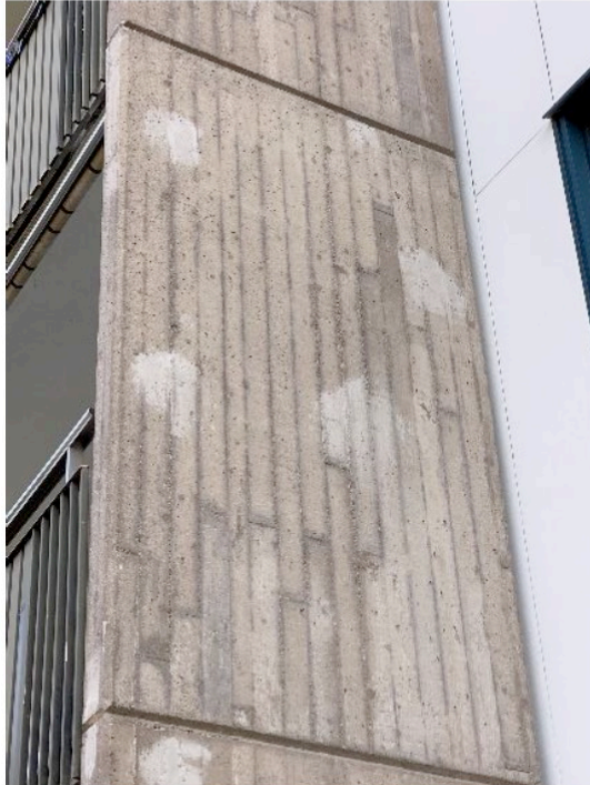
Skärmväggar med lagningar.
