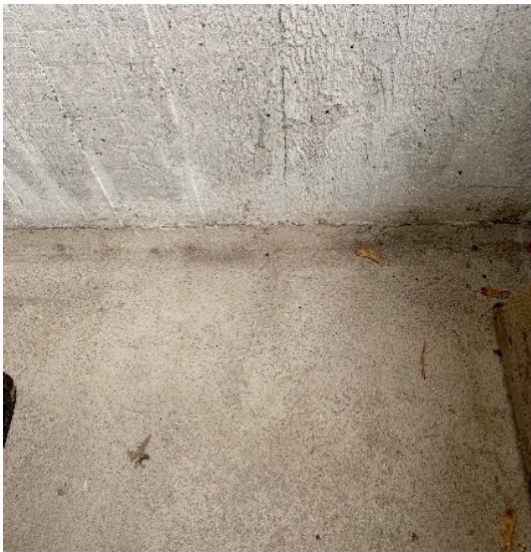
Sprickor i hålkäl.
